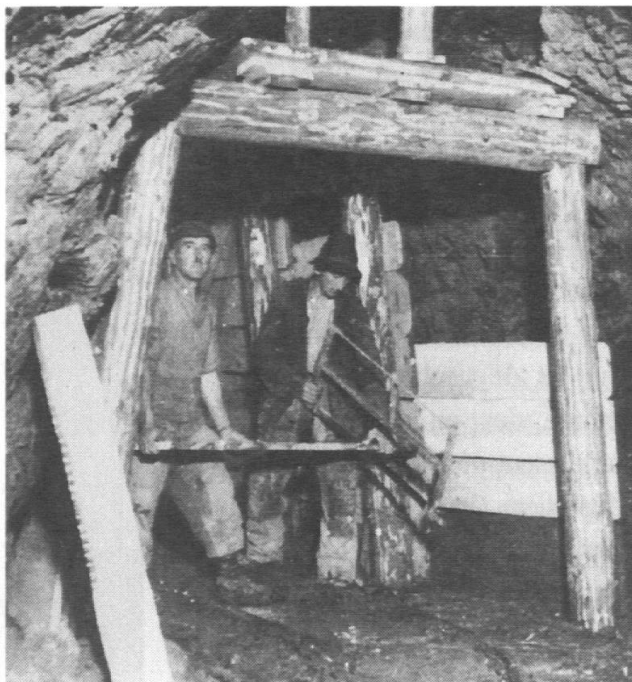
Des boiseurs à l'ouvrage.
