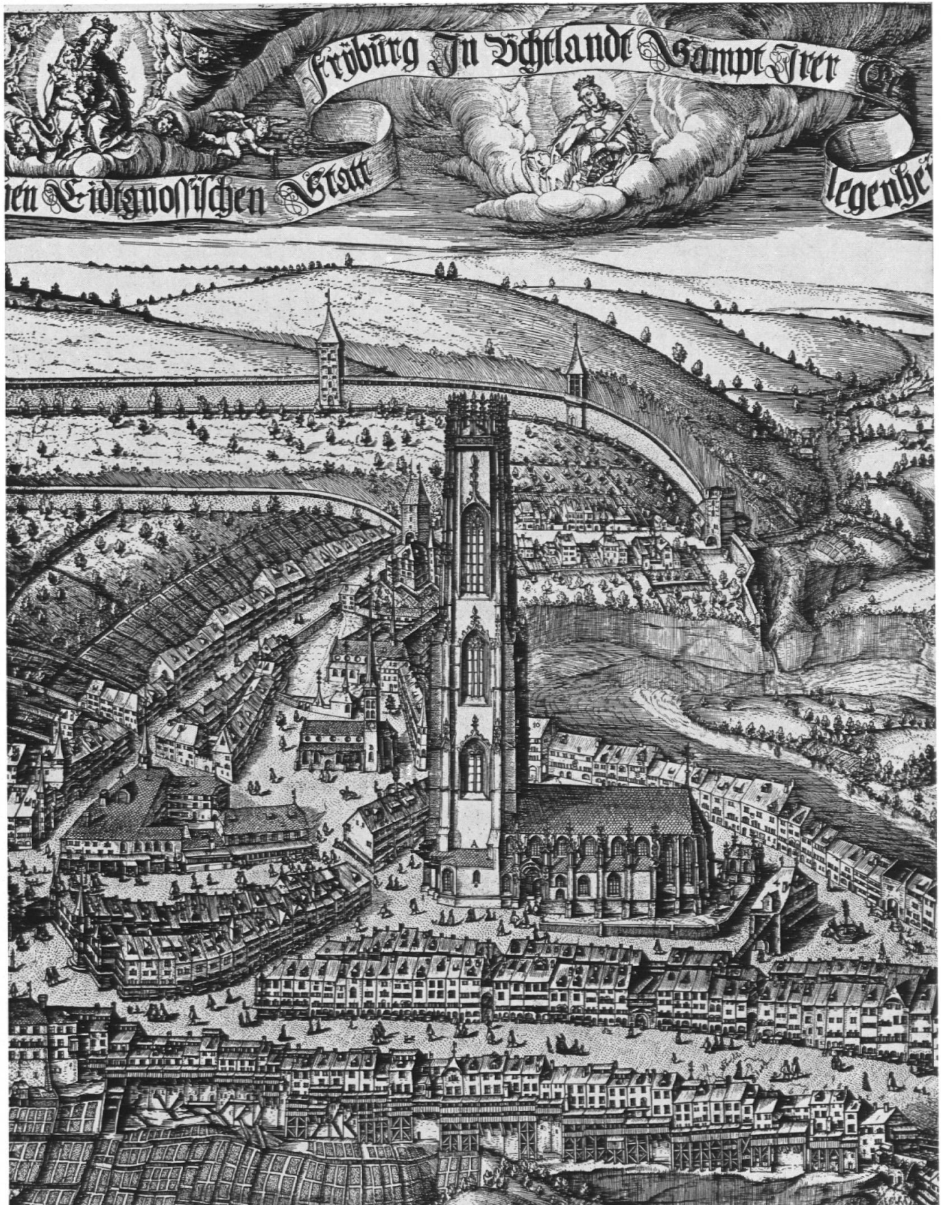
Détail du panorama de Fribourg gravé en 1606 par Martin Martini. Est marquée par la lettre D l'église des Cordeliers, par I la chapelle de Notre-Dame de Compassion ou du Saint-Suaire, et par V la petite toiture abritant le crucifix du cimetière; ledit cimetière occupait une partie du terrain enclos de murs que l'on distingue nettement.
