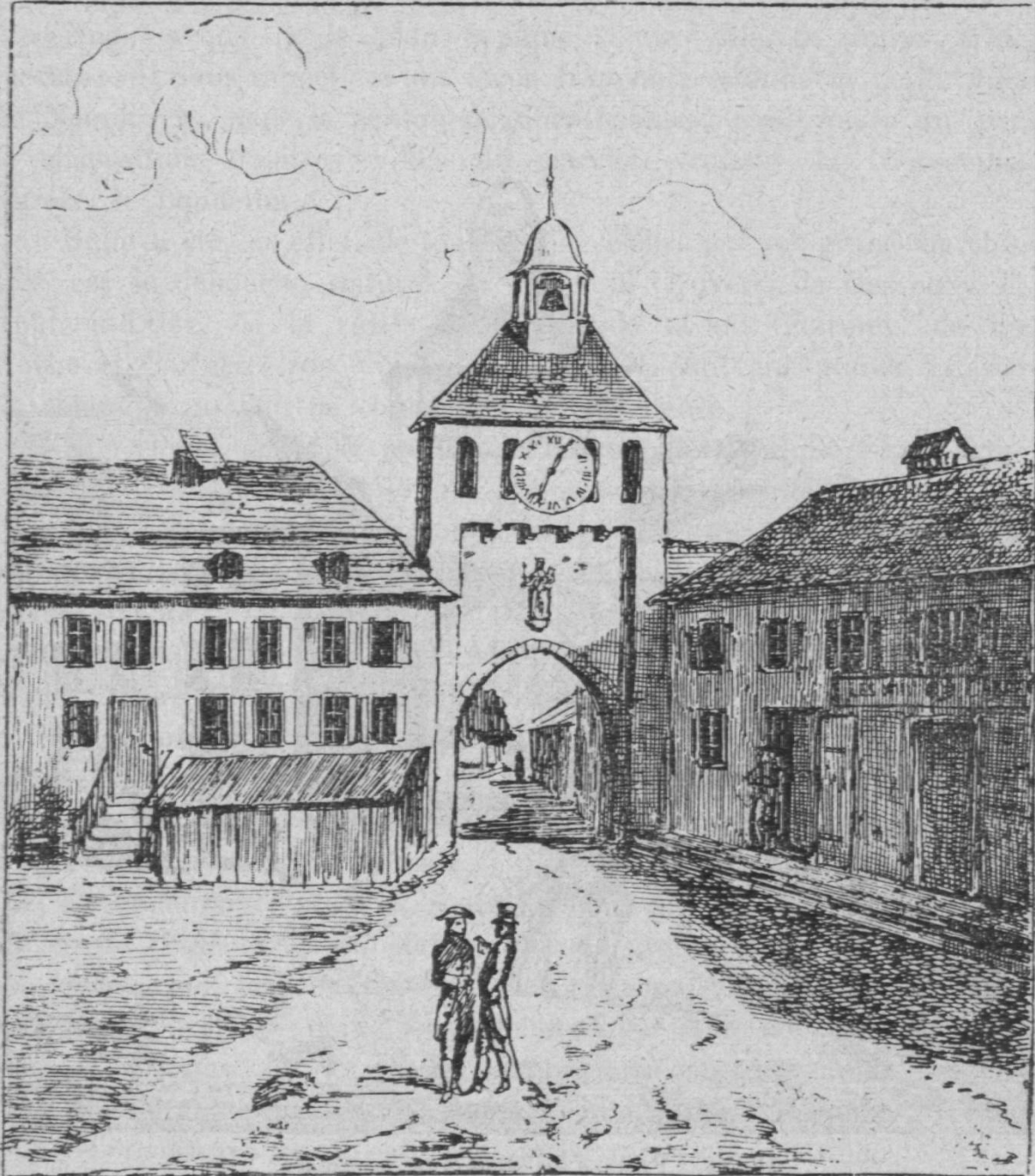
Fig. 2. Porte d'En-Haut vue extérieure.
