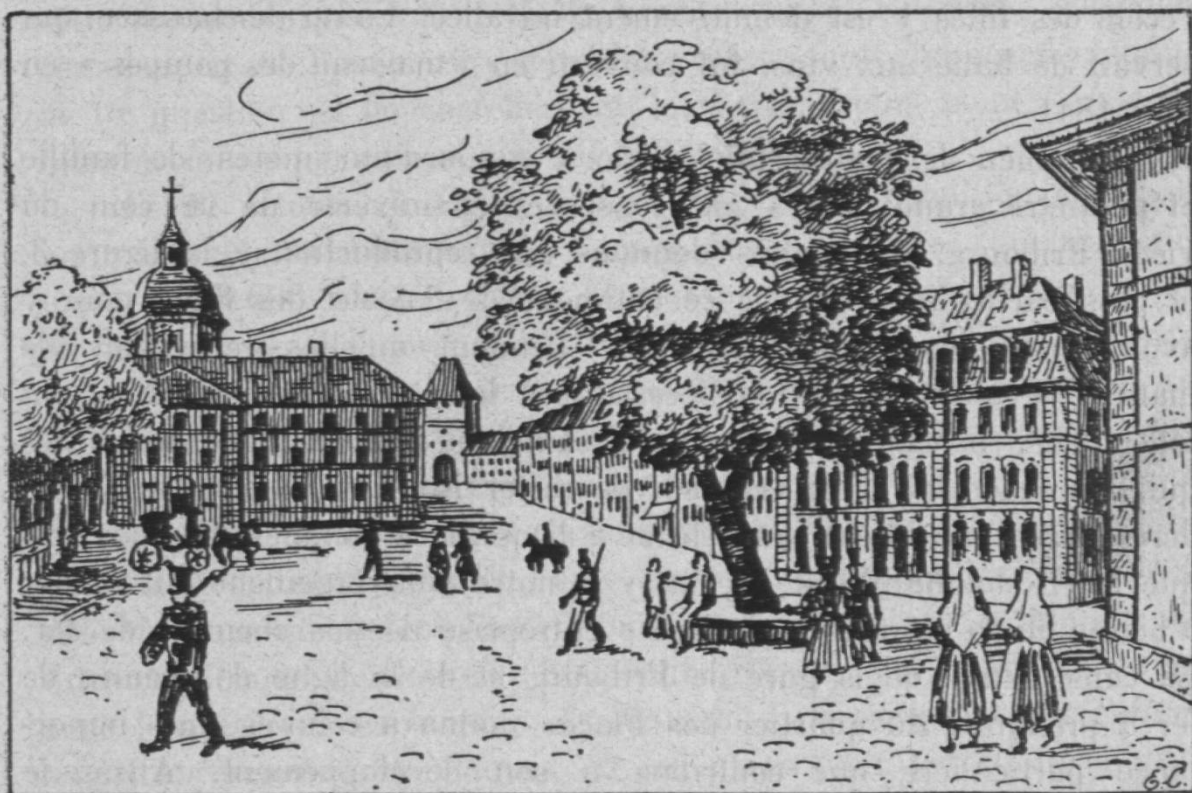
L'Hôpital et la Caserne sur la place des Tilleuls. Yverdon, Suisse.
