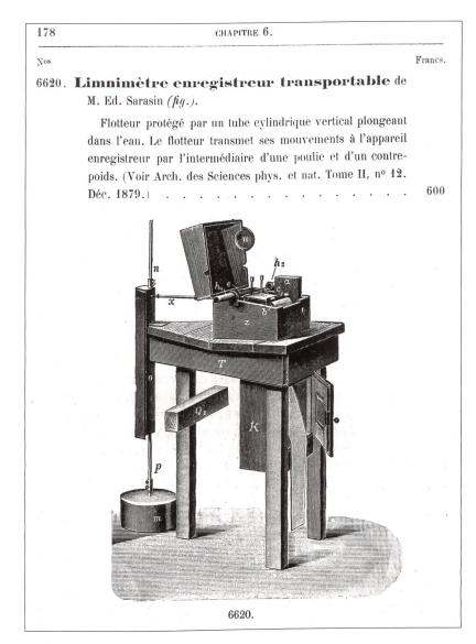
enregistreur transportable. La description technique est sommaire: un flotteur protégé par un tube cylindrique vertical plongeant dans l'eau. Le flotteur transmet ses mouvements à l'appareil enregistreur par l'intermédiaire d'une poulie et d'un contrepoids (SIP 1903; p.178) (Fig. 9).
