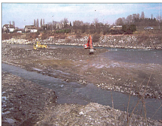
Fig. 7: Remobilisation d'un banc de gravier – Annemasse (Source: SLAEAB 2004)
