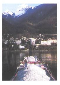
Fig. 61. Immersion de gravier le 19/11/98 sur l'omblière de la Veraye.
