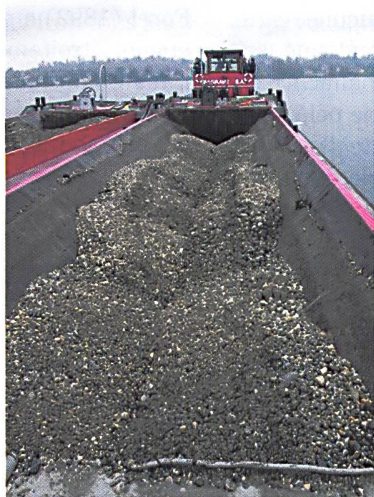
Fig. 66. Immersion du gravier au large de Nyon.
