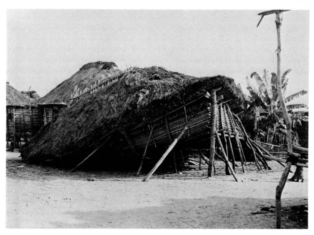
Fig. 2. — Village de So-Tchanhoué (R. P. du Bénin). Une maison ruinée s'effondre sur un sol asséché. Les ruines de l'architecture disparaîtront rapidement par décomposition ou réemploi. A la crue suivante, le reste des matériaux sera entraîné par l'eau et dispersé hors du village.
