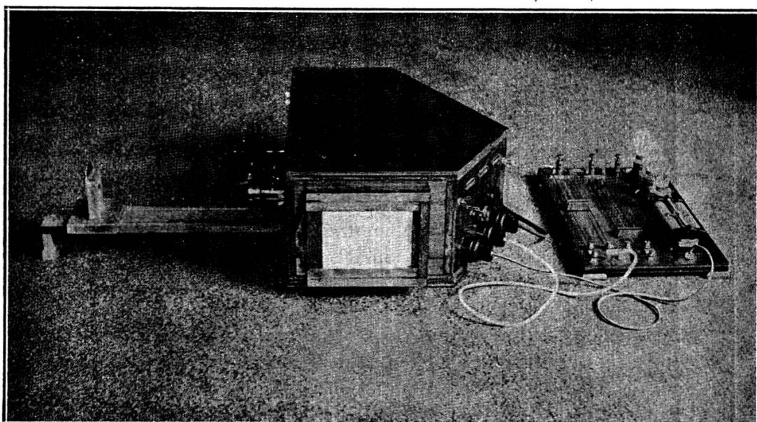
enregistrées. La durée d'oscillation propre de la boucle est variable et peut être abaissée jusqu'à  $1/1500^{\circ}$  de seconde environ. Dans le voisinage de  $1/900^{\circ}$  de seconde, on obtient sur le verre dépoli de l'appareil une déviation de 1 cm. avec un courant continu de 0.48 ampère ; en projetant sur un grand écran, on a une déviation proportionnellement plus grande.
