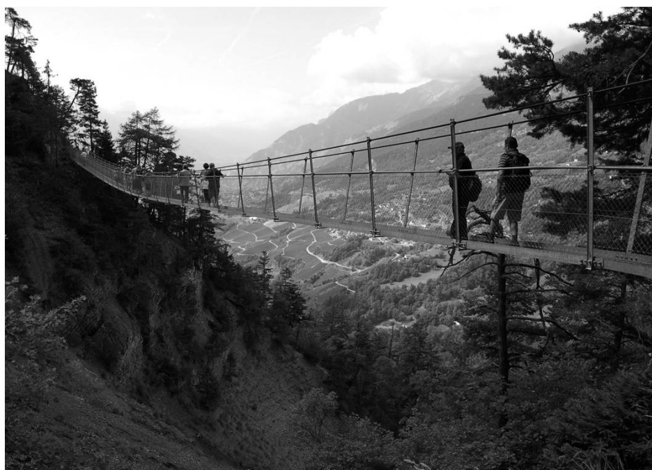
Bisse de Savièse. Passerelle. Photo Bretz, 2010.
