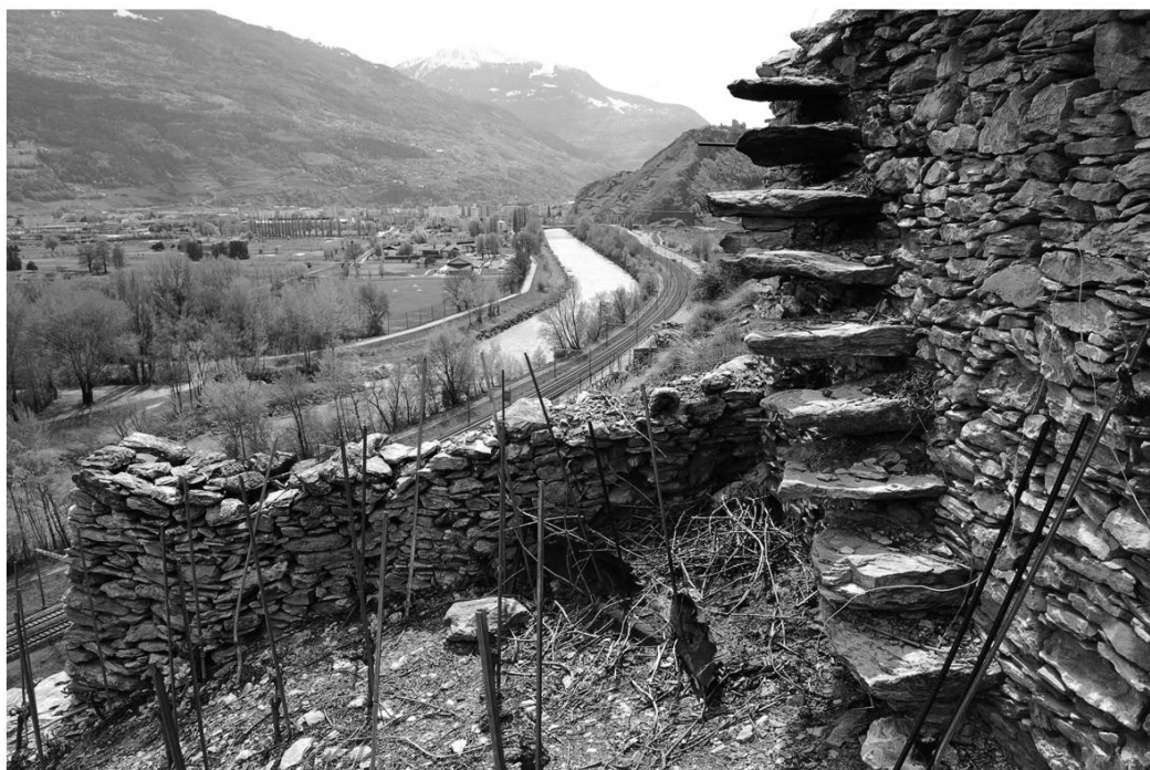
Escalier du parchet de Clavoz entre Sion et Uvrier surplombant le Rhône.
