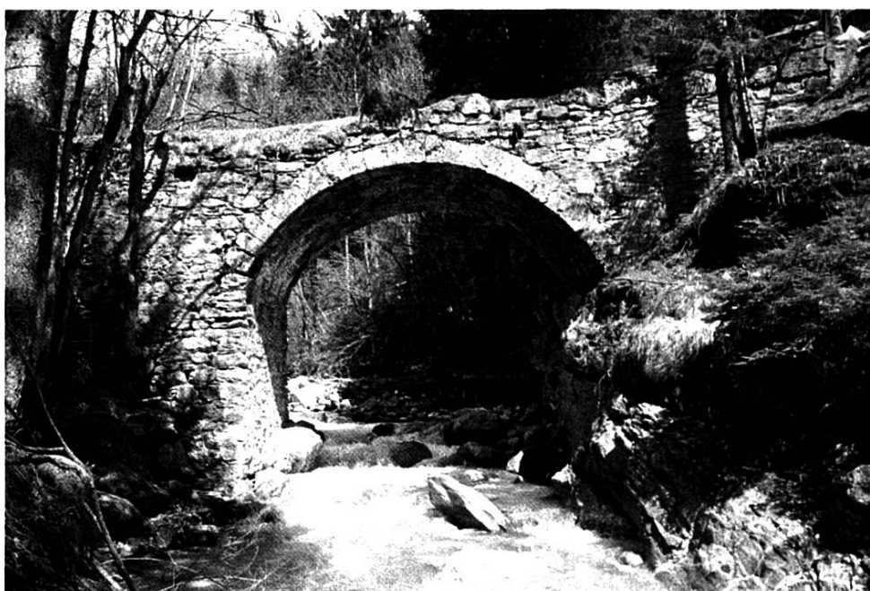
Pont sur la Dala (VS), construit par Ulrich Ruffiner en 1539. Photo Bretz, 2006.
