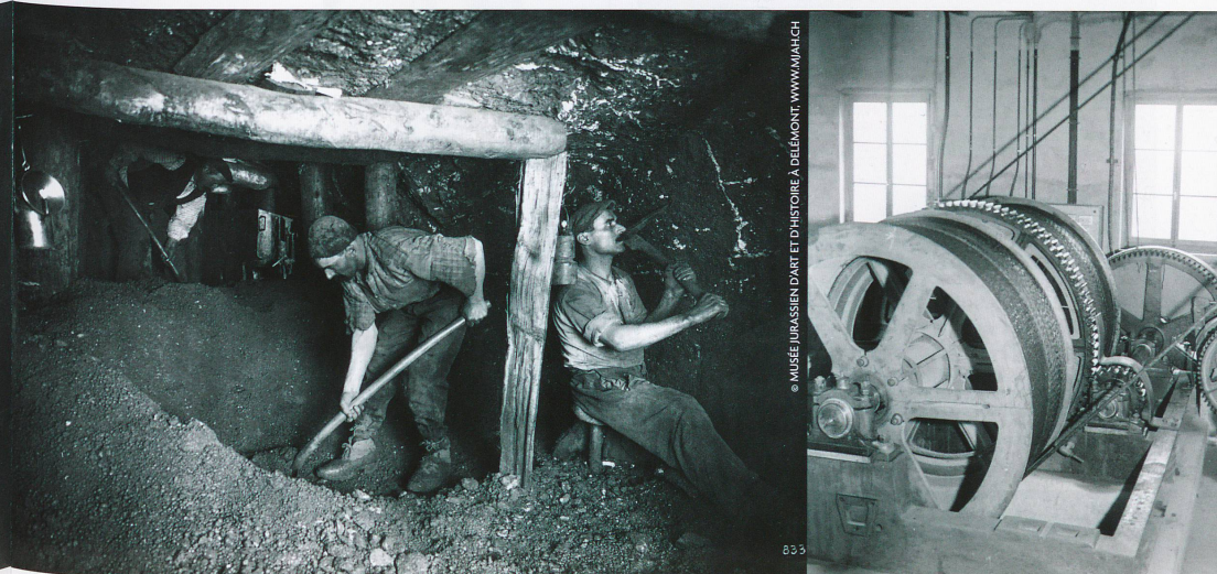
À gauche : équipe de mineurs abattant le minerai et le chargeant sur un wagonnet. À droite : machinerie de l'ascenseur dans une tête de puits.
