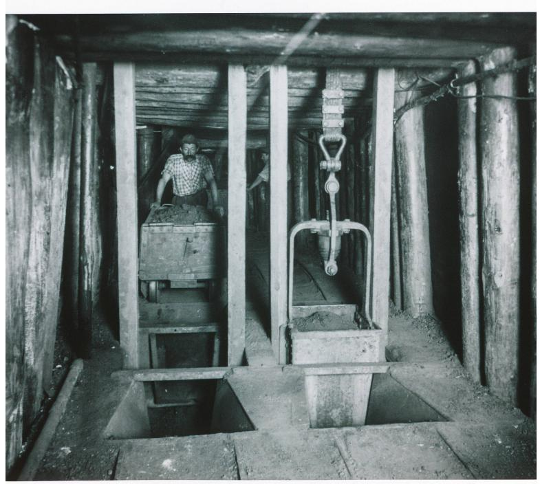
Puits de mine à Delémont: chargement du minerai dans le cuveau qui le remontera en surface.
