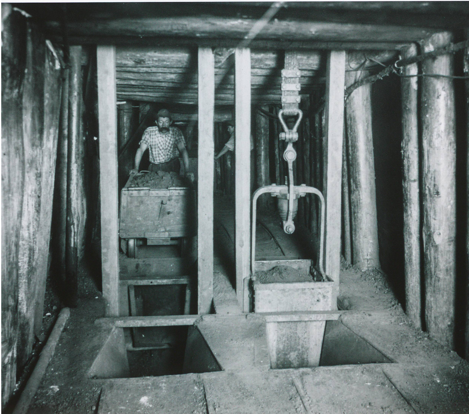
Puits de mine à Delémont: chargement du minéral dans le cuveau qui le remontera en surface.
