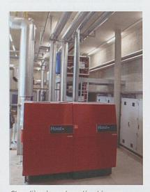
Chaudière à condensation bi-corps de 1150 kW
