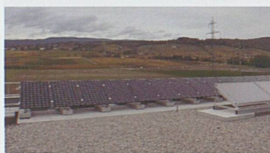
Panneaux solaire thermiques et photovoltaïques
