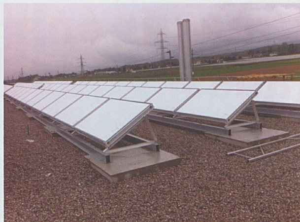
Panneaux solaires thermiques
