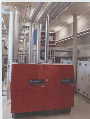
Chaudière à condensation bi-corps de 1150 kW
