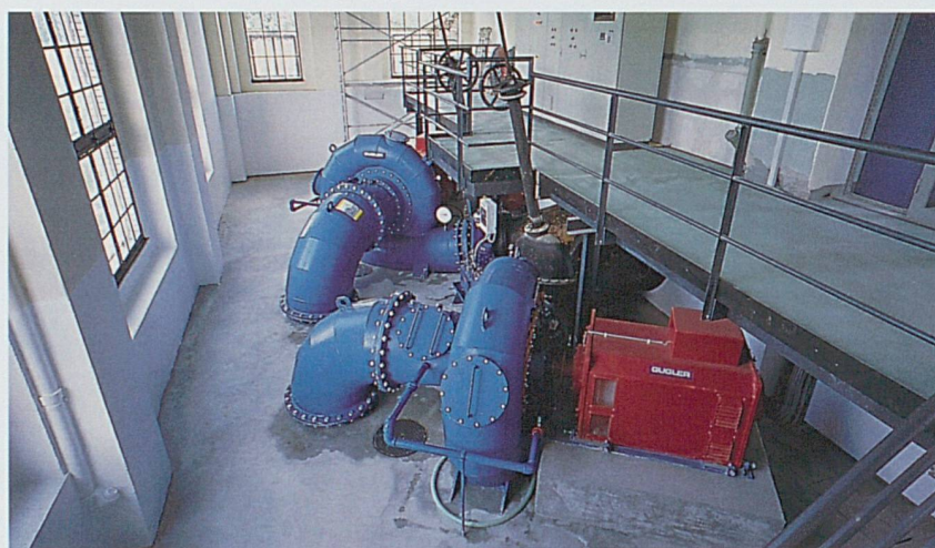
Intérieur centrale Dynamo sur la Birse au nord de Courrendlin, puissance 380 kW, production annuelle, de l'ordre de 1,5 millions de kWh
