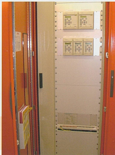
Armoire « relayage » Beuchille avec relais de protection numériques
