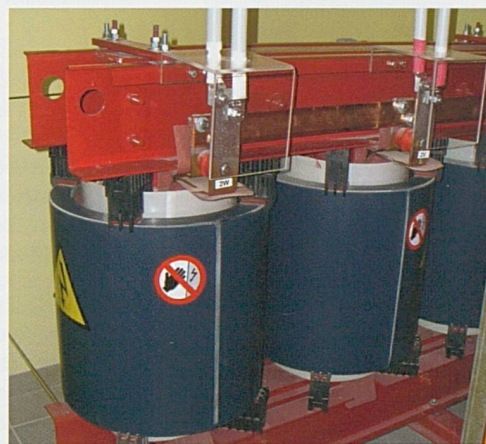
Transformateur de distribution 16/0,4 kV, 400 kVA, type sec
