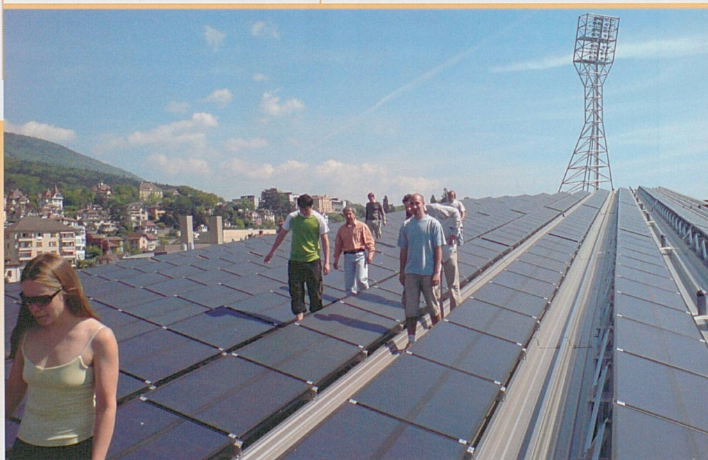
Module en Si couche mince sur le toit du stade de la Maladière à Neuchâtel
