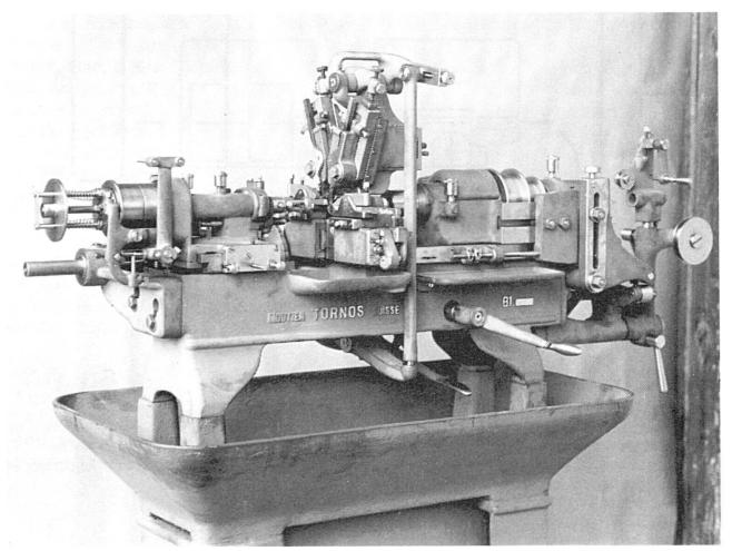
Tour automatique à poupée mobile construit par Tornos dès les années 1930. On distingue, de droite à gauche, la poupée mobile, puis les porte-outils et les burins et, enfin, le dispositif d'embout (document Tornos SA, Moutier).
