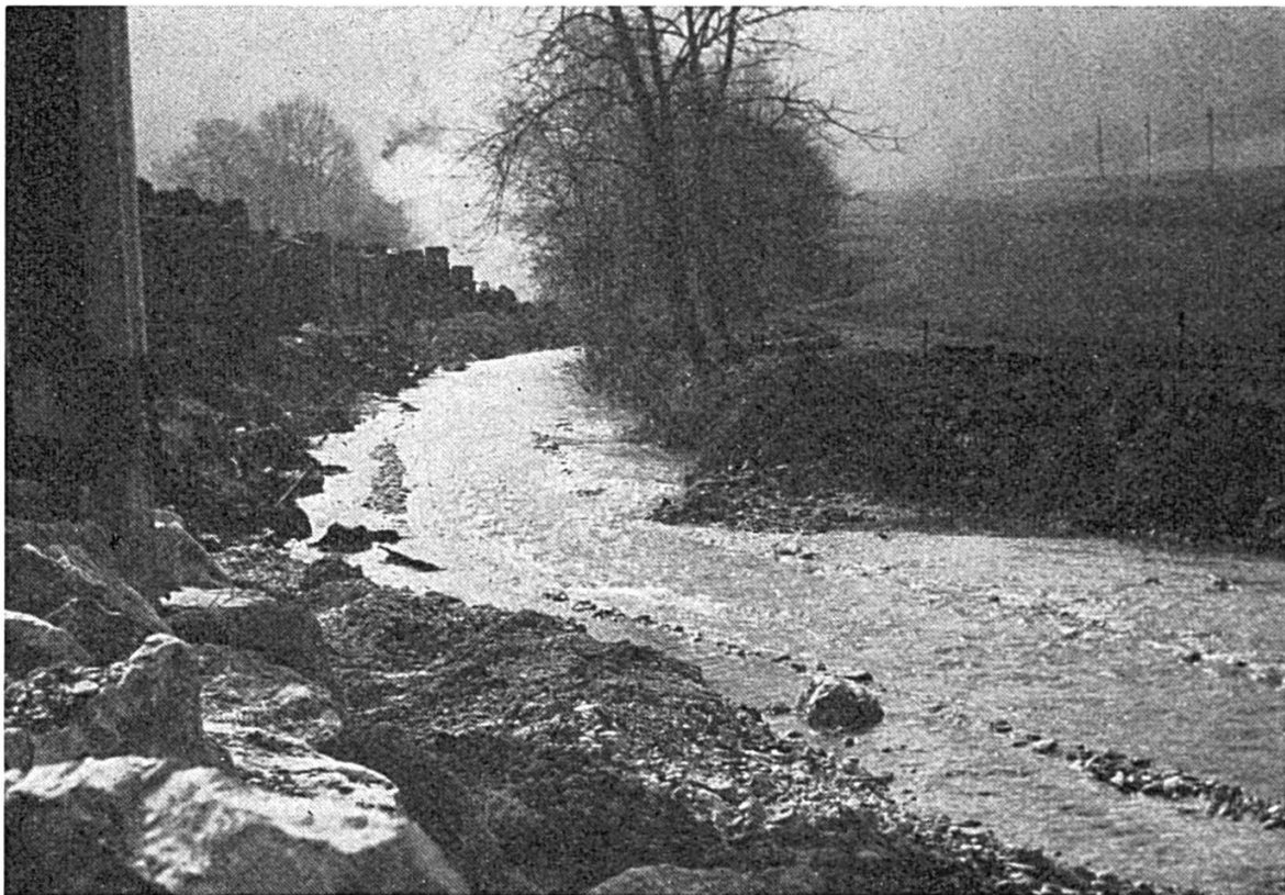
Fig. 11 Enrochement le long de la Scheulte à Vicques. Photo F. Bachmann.
