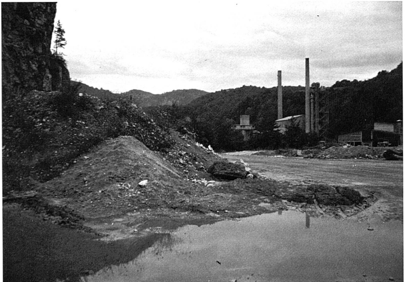
Point d'eau dans glaisière
