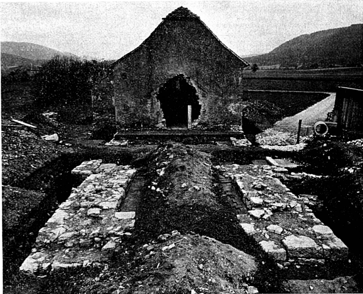
Vue générale des fouilles extérieures.
