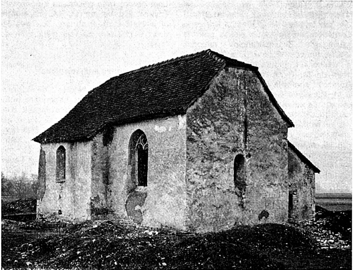
Aspect de la chapelle avant la rénovation.
