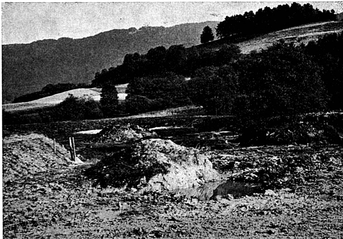
Etang des Chaux-Fours pendant les travaux.
