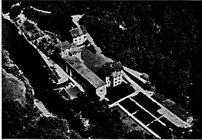
USINE DE LA GOULE SUR LE DOUBS
