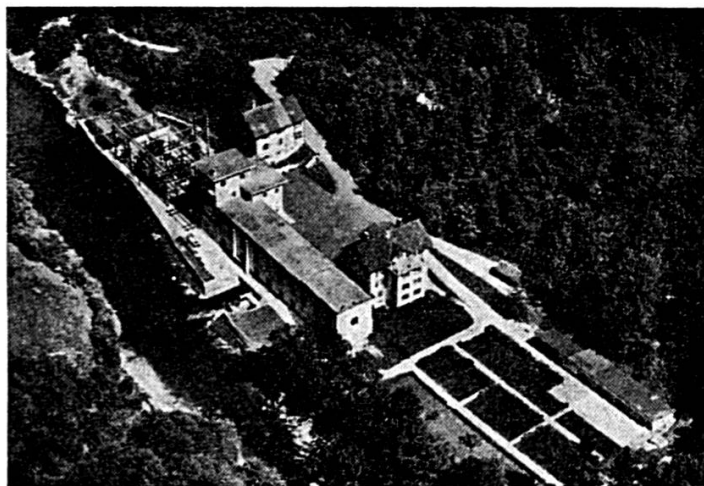
USINE DE LA GOULE SUR LE DOUBS
