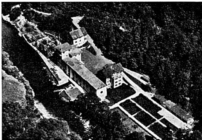
USINE DE LA GOULE SUR LE DOUBS
