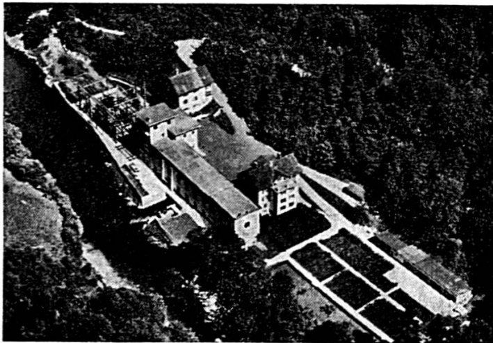
USINE DE LA GOULE SUR LE DOUBS
