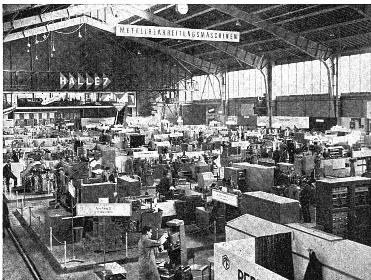
Deux grandes halles couvrant ensemble 10 000 m 2 de surface sont à la disposition du groupe des machines à la Foire de Bâle.
