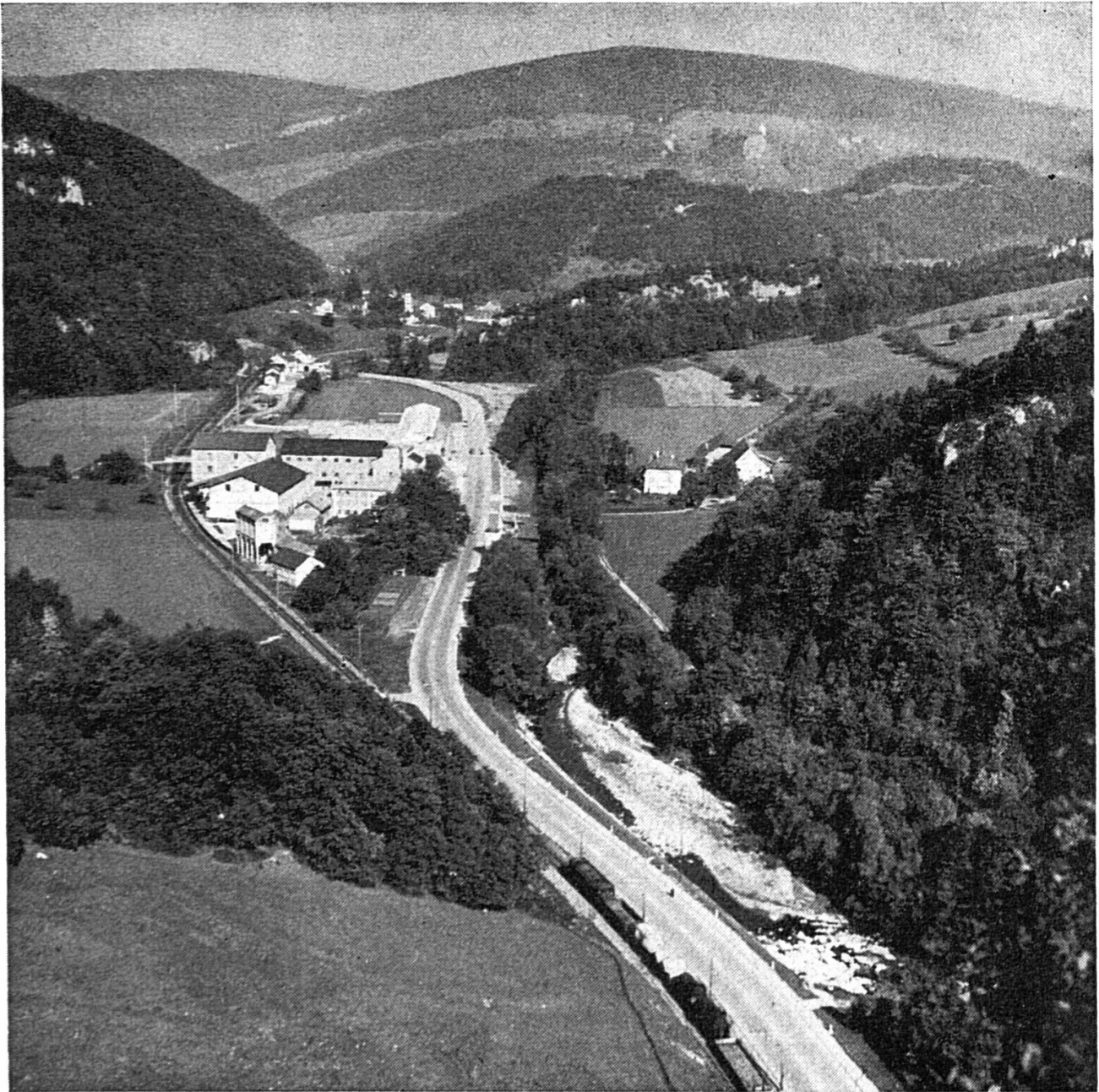
La voie unique entre Delémont et Aesch, à Soyhières
