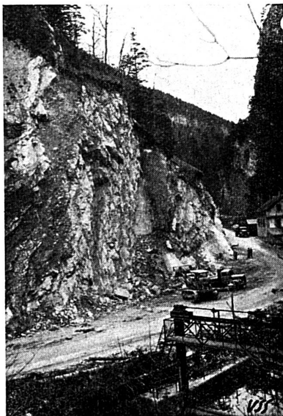
Fig. 4. Abattage de la falaise (hauteur 34 m.)
