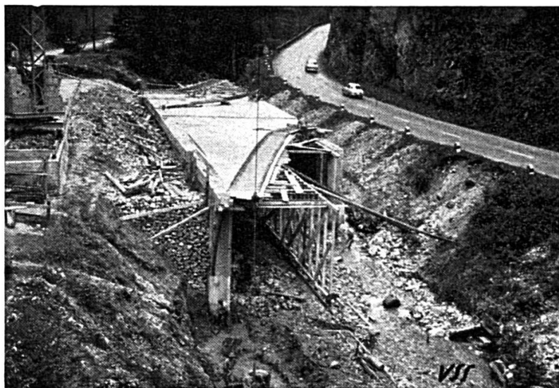
Fig. 6. Le pont amont en construction, après le bétonnage de la dalle biaise
