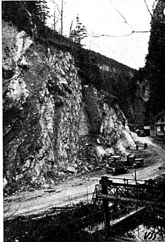
Fig. 4. Abattage de la falaise (hauteur 34 m.)
