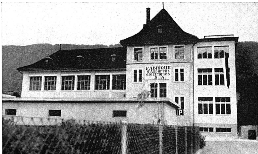
La Fabrique EAB, qui vient de se doter, à droite, d'une nouvelle annexe, là où flotte le drapeau jubilaire.
