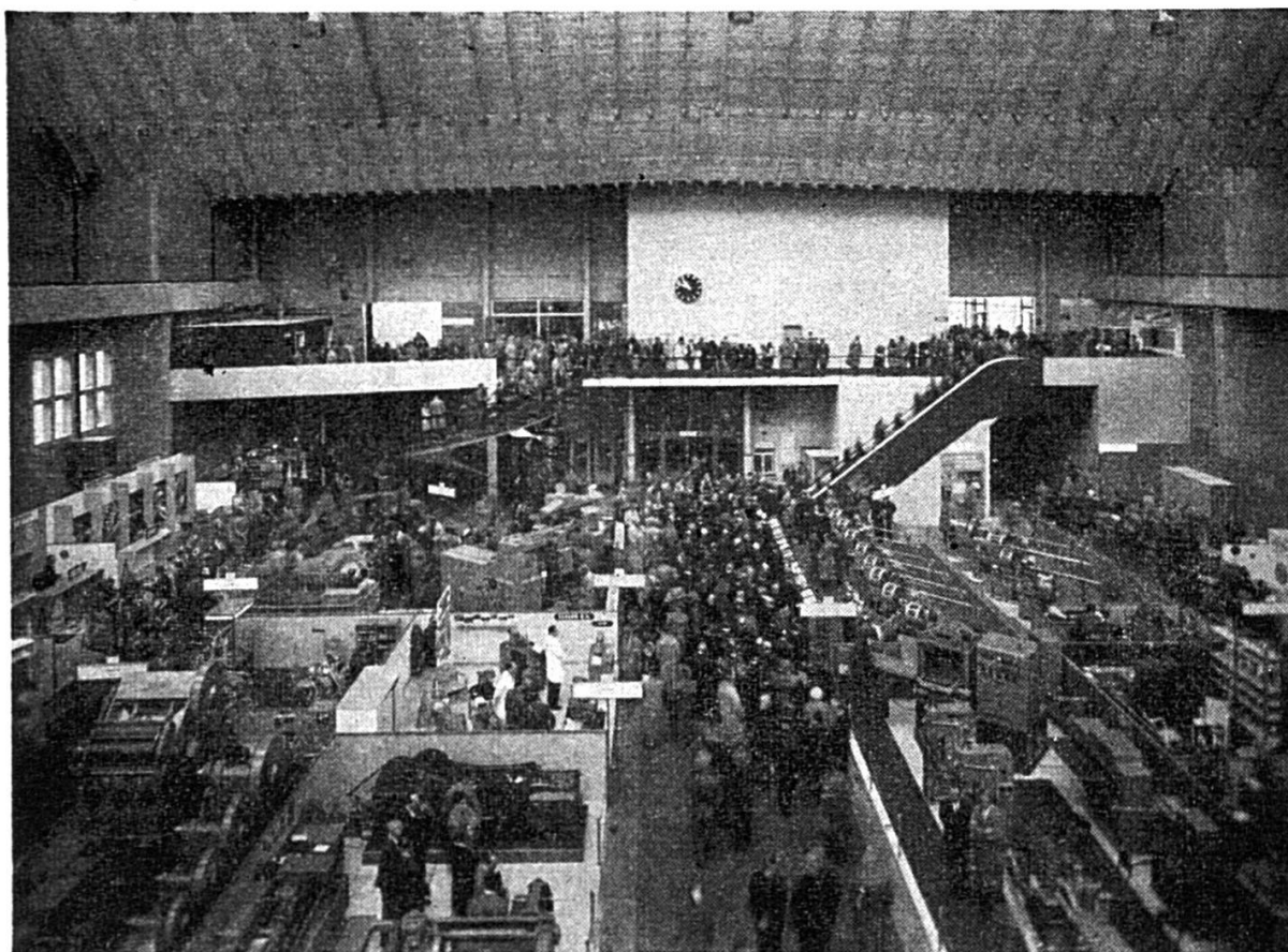
La dernière en date des halles de la Foire Suisse d'Echantillons de Bâle, réservée en 1958 aux machines-outils, abritera en 1959 une section de manutention rationnelle.
