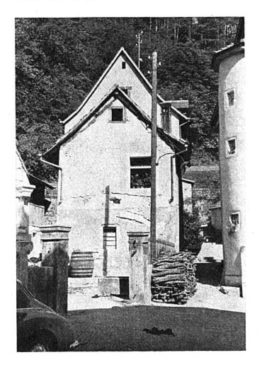
Vue depuis la route du bâtiment avant la restauration. L'arc maçonné de la voûte du rez-de-chaussée est bien visible.
