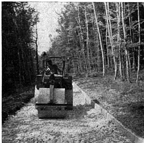
Compactage de la chaille avec cylindre
