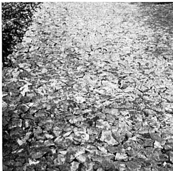
Première couche de chaille compactée
