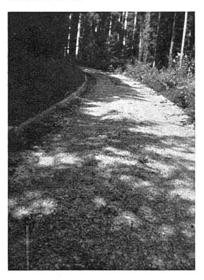
Profil classique : 25 cm. empierrement + 10 cm. gravier : usure exagérée. Ramassage des pierres d'empierrement au milieu, par compression du camion.
