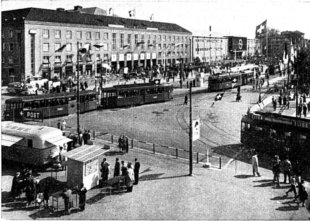
Vue sur la place qui s'étend devant les deux bâtiments principaux de la Foire
