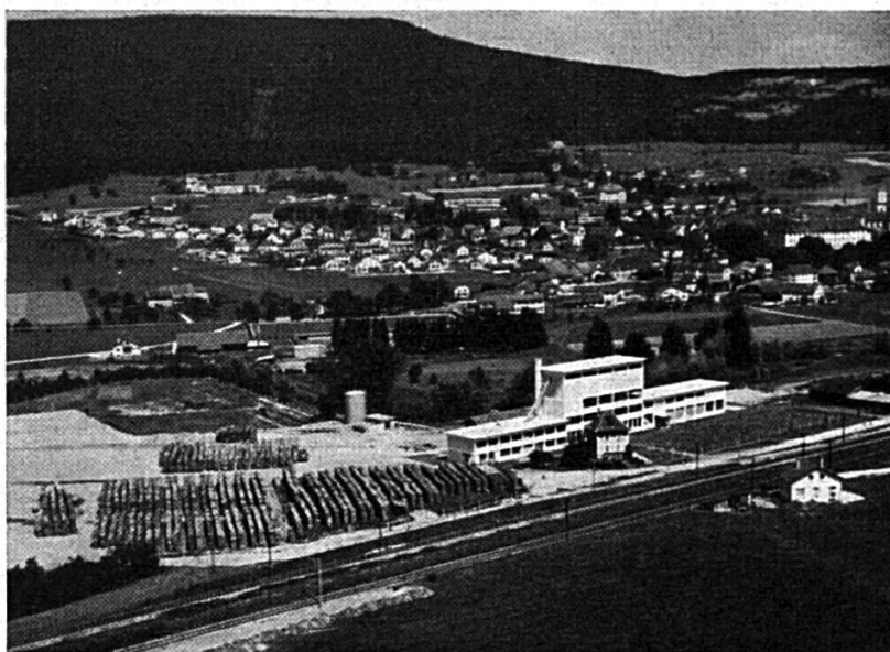
Vue générale de l'emplacement : A gauche, chantier de bois avec canal transporteur. — Au milieu, légèrement dans le fond, tank à huile lourde et station de pompage. — A droite, l'usine
