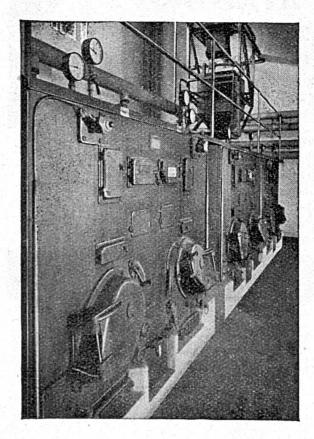
Chaufferie à 6 chaudières d'une grande usine «Chauffage et chargement automatique au charbon.»
