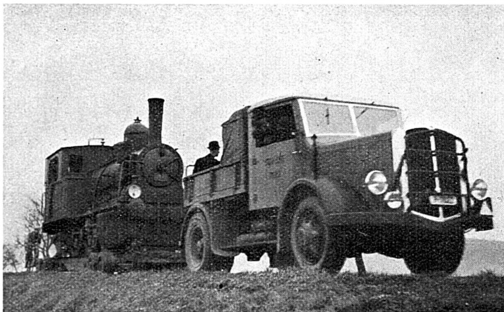
La route au secours du rail !
