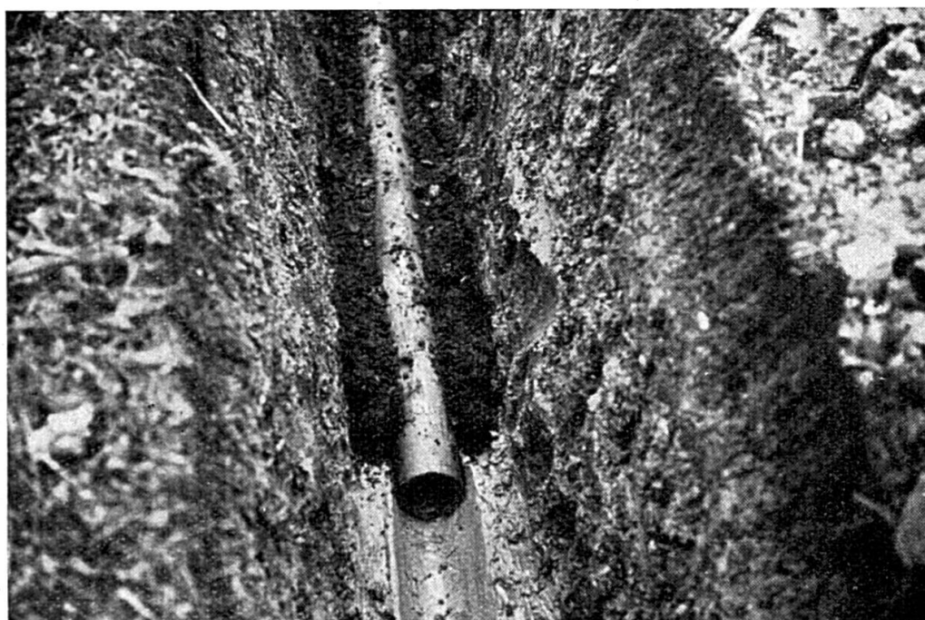
Canal formé de drains couchés dans la tranchée. On remarque la gorge qui forme l'assise, puis les tuyaux de terre et le remblai fait de terre perméable.
