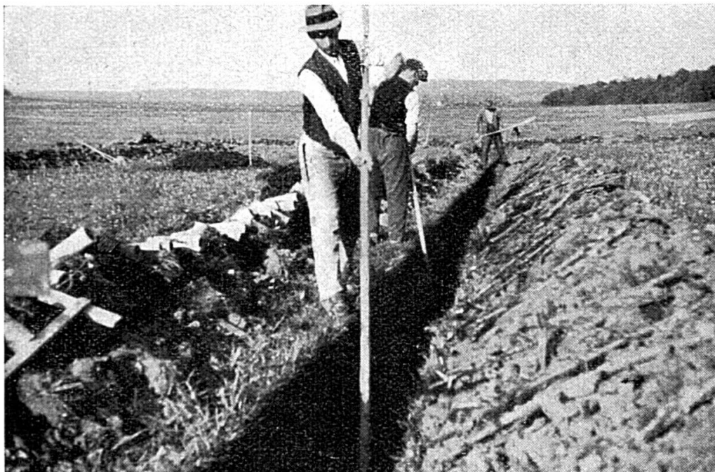
Travaux d'assèchement à Beurnevésin. — Le drainage. — Le maître draineur creuse, au fond du fossé, une gorge dans laquelle les drains seront couchés.
