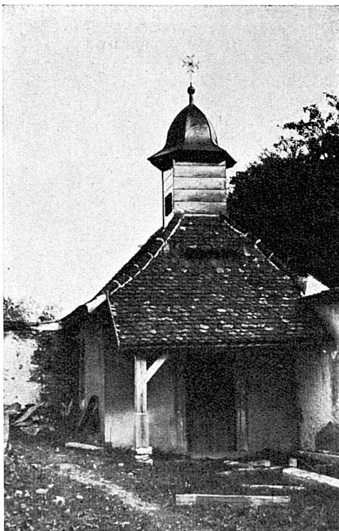
La chapelle rénovée de Raymontpierre. (Photo M. Lachat)
