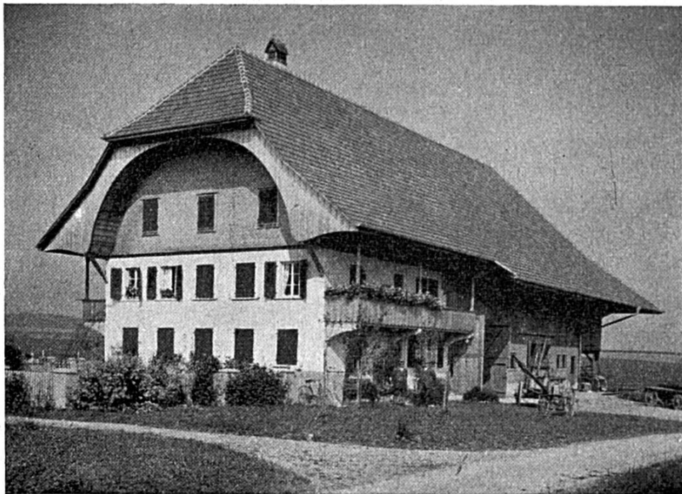
(Fig. 8.) La nouvelle colonie de Bendicht Schär à Zauggenried. Type de la ferme bernoise : toutes les parties de la ferme sous le même toit avec un seul faite.
