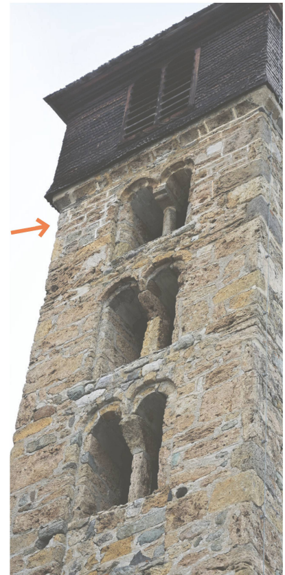
Abb. 4: Samedan, Kirchturm San Peter 2023. An der Fassade des obersten Geschosses und am Gesims zeichnet der mit Kalkschlämme weiss gefärbte Fugenputz eine Quadrierung nach (Pfeil). Darunter ist im Mörtel die Quadrierung durch Fugenstrich ausgezeichnet. Blick gegen Westen.
