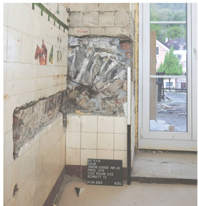
Abb. 2: Chur, Obere Gasse Nr. 43, 1. Obergeschoss. Rundbogige Fensteröffnung in der Südmauer. Blick gegen Süden.
