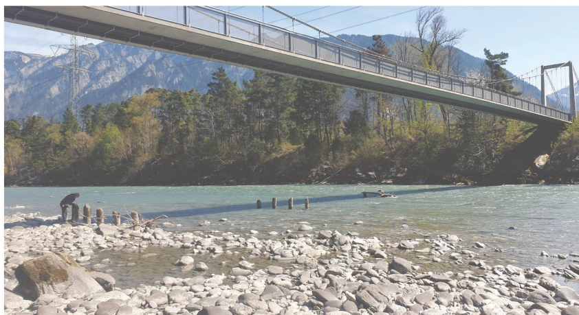
Abb. 1: Chur, nördliches Rheinufer, Holzpfähle unterhalb der Pardislabrücke während der Probenentnahme für die dendrochronologische Altersbestimmung am 8. April 2025. Blick gegen Südosten.
