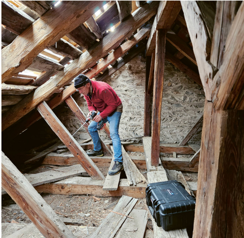
Abb. 2: Domleschg, Paspels, Kirche Sogn Luregn 2023. Dendrochronologische Probenentnahme einer 1771 (Bau 3) wiederverwendeten Strebe von 1208 (Bau 2) im Dachstuhl über dem Schiff. Blick gegen Osten.
