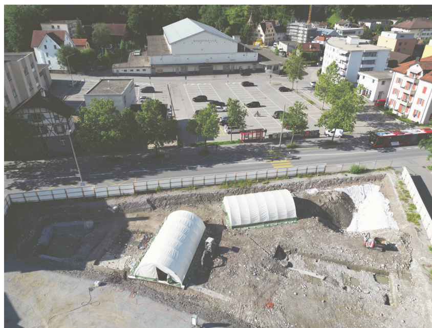
Abb. 1: Chur, Welschdörfli, Kasernenstrasse. Überblick Grabungsfläche. Im Hintergrund die Stadthalle mit Parkplatz unter dem sich die Reste der römischen Siedlung bzw. des römischen Bades befinden. Blickrichtung gegen Süden.
