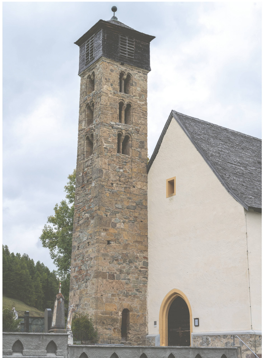
Abb. 1: Samedan, Kirchturm San Peter. Der romanische Turm stand ursprünglich an der Westseite des vorromanischen Langhauses, das 1491/1492 durch den gotischen Bau mit Langhaus und polygonalem Chor ersetzt wurde. Blick gegen Nordosten.
