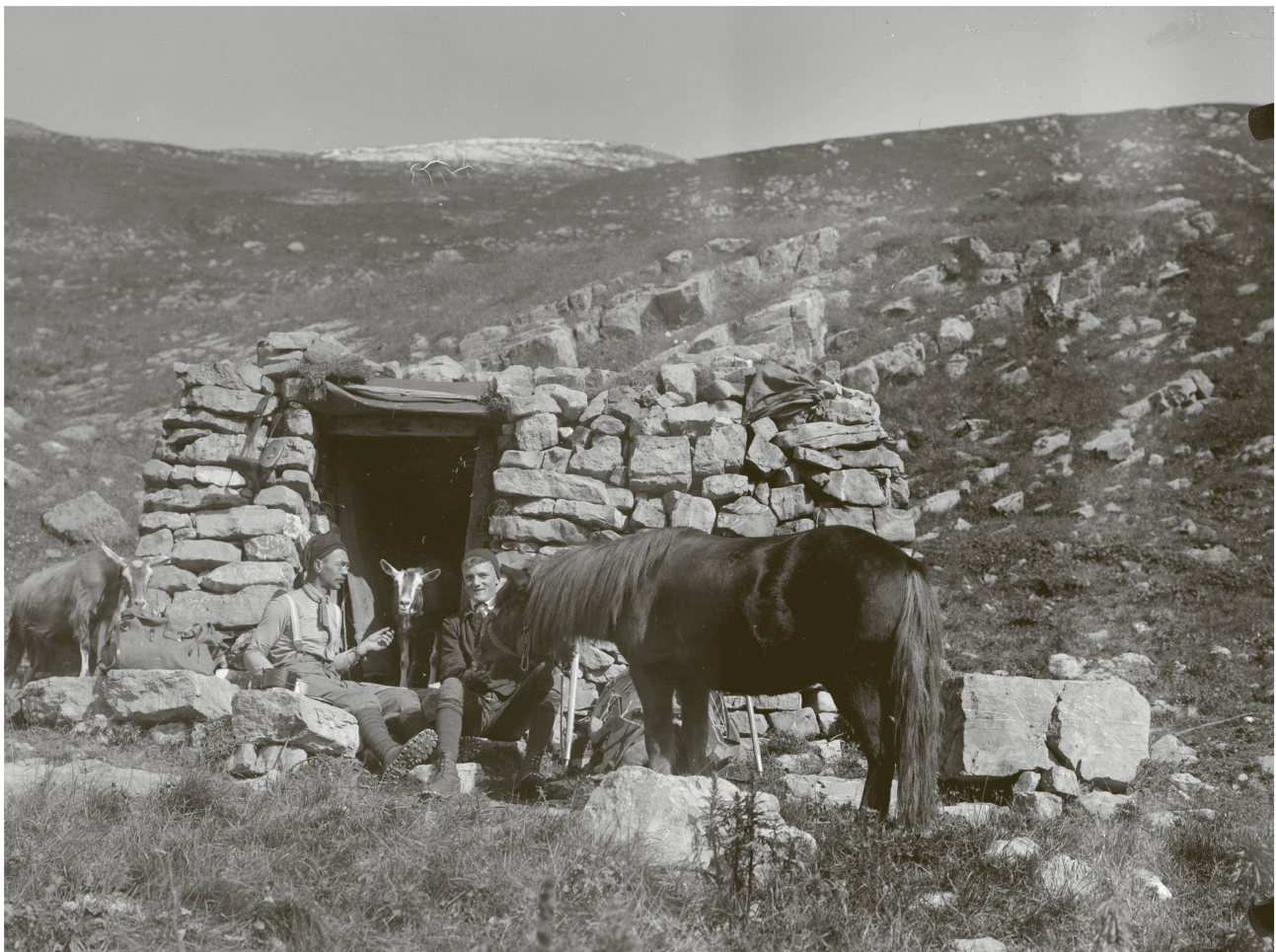
Abb. 12: Gebäude auf Alp Murter, um 1915. Blick Richtung Osten / Fuorcla Murter. Auf dem Foto sind Hermann Langen und ein Begleiter sowie das Pony «Hans» und zwei Ziegen erkennbar.
