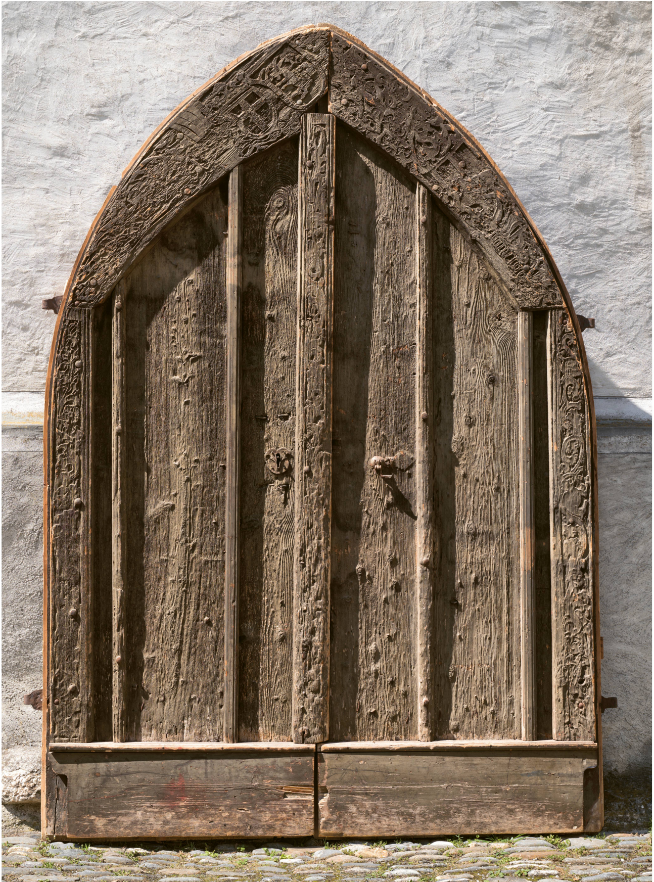
Abb. 2: Ilanz, St. Margarethen. 2024. Aussenseite der spätgotischen Kirchentüre.
