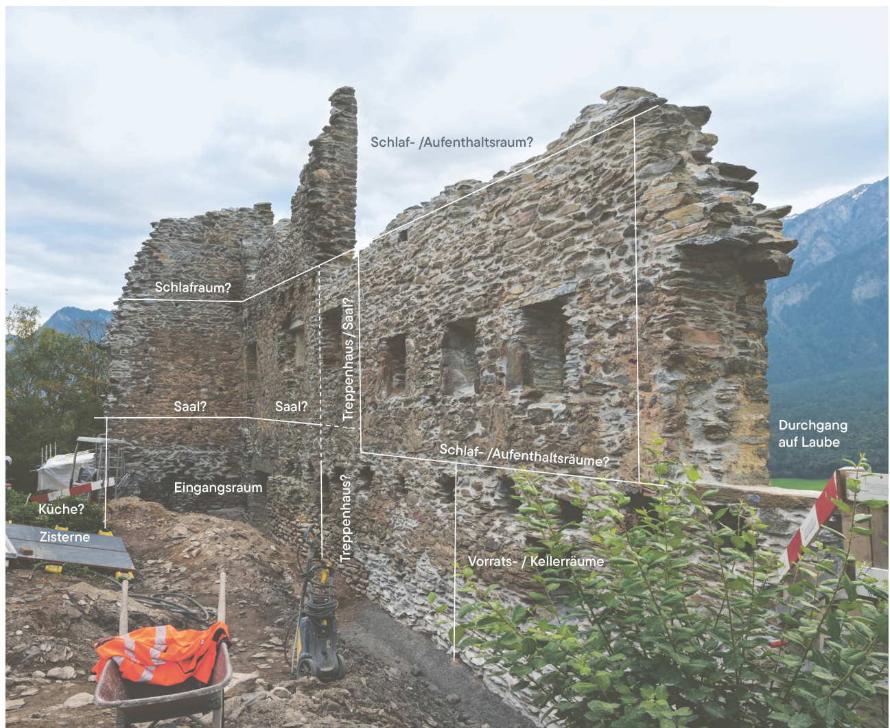
Abb. 5: Chur. Haldenstein, Burgruine Lichtenstein 2024. Innenansicht während den Konservierungsarbeiten. Einteilung der Räume zur Veranschaulichung. Blick gegen Nordosten.
