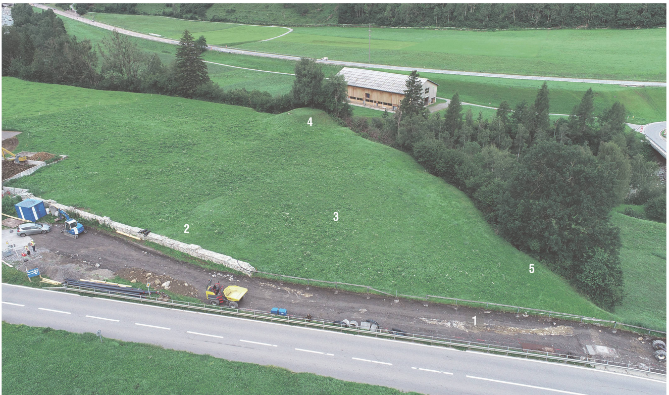
Abb. 1: Zillis-Reischen, Hasenstein und Bot da Mulegn. Drohnenaufnahme vom 3. August 2021. 1 Maschinell freigelegte Umfassungsmauer. 2 2015 im Rahmen eines Burgenkurses rekonstruierter Mauerabschnitt. 3 Ehemaliges Burggelände. 4 Standort Turm. 5 Erosionsböschung. Blick gegen Westen.
