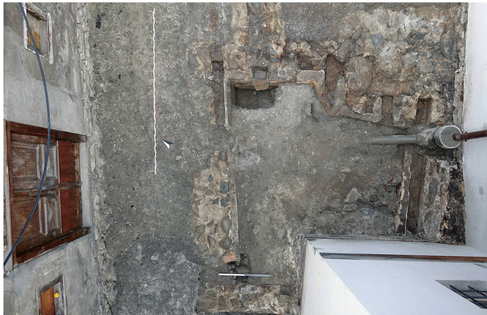
Abb. 4: Malans, Neugestaltung Dorfkern. 2021. Neuzeitliches Sicker- oder Sammelbecken zwischen Rathausstall und Rathaus.
