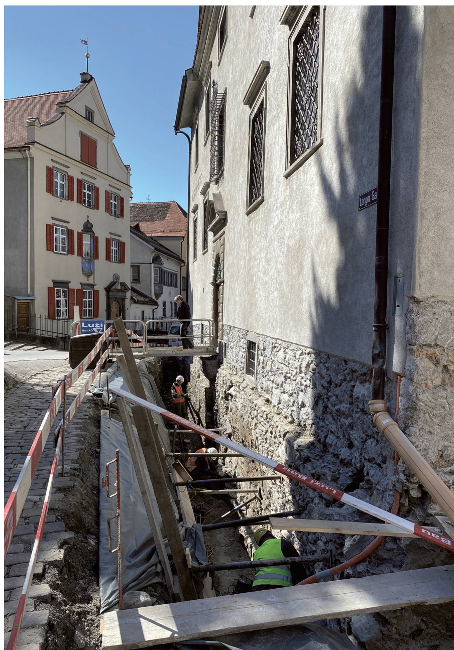
Abb. 1: Chur, Altstadt, Rätisches Museum 2021. Blick in den ausgehobenen Drainagegraben an der Südseite des Buolschen Hauses (Rätisches Museum). Reinigungsarbeiten an der partiell freigelegten Südfassade. Blick gegen Westen.
