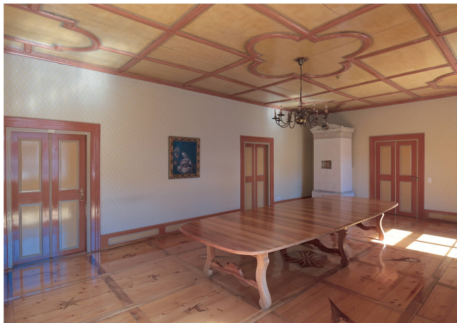
Abb. 7: Chur, Hof, Bischöfliches Schloss, Etappe 4. Verwalterhaus, 2. Obergeschoss. Saal mit Ofen, Felderdecke und Tafelparkett mit Intarsien (Reichsadler, Sterne, Lilien, Tiere). Tafelparkett von Bischof Joseph Benedikt von Rost (1728–1754) in Auftrag gegeben. Zustand vor dem Umbau. Blick gegen Norden.
