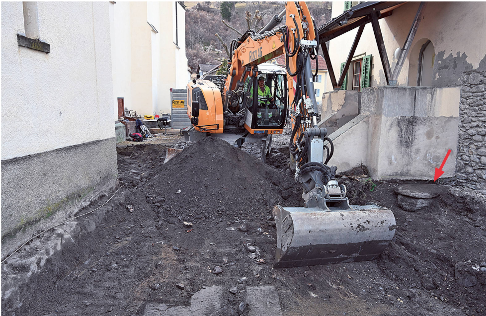
Abb. 4: Cazis, Pfrundhaus. 2022. Fundlage des Steinsarkophags mit Deckplatte direkt neben dem Treppenaufgang ins Pfrundhaus (Pfeil). In diesem Sarkophag sollen die Reliquien des Heiligen Victor von Tomils aufbewahrt worden sein. Blick gegen Westen.
