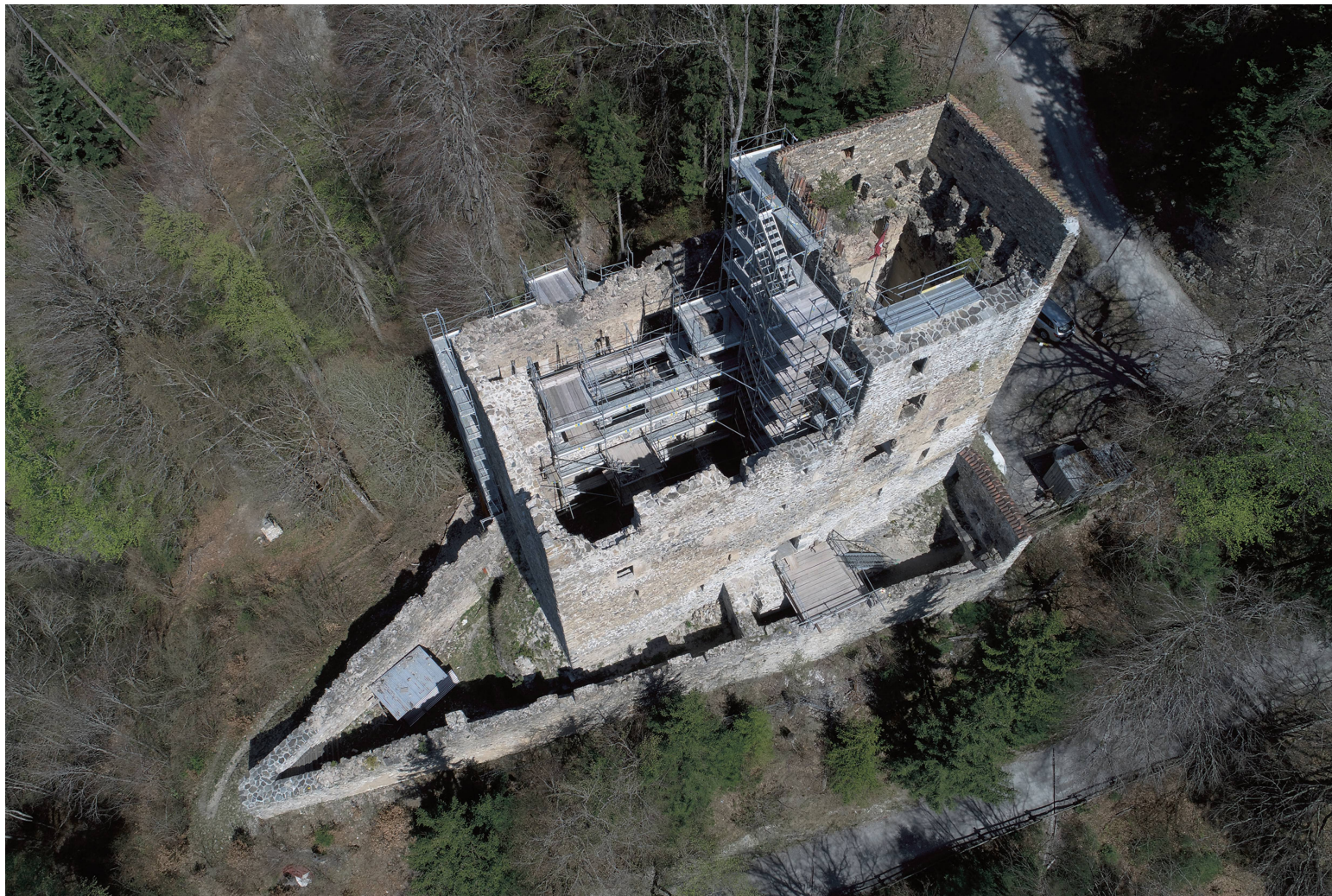
Abb. 1: Jenins. Burganlage Neu-Aspermont. 2018. Sanierungsetappe des Nordtraktes. Blick gegen Nordosten.
