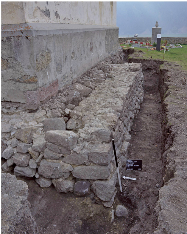
Abb. 2: Samedan, Kirche San Peter 2016/2017. Freigelegte Süd-mauer der Vorgängerkirche. Das Fundament des spätgotischen Nachfolgebaus durchbricht die Baureste des Vorgängers zur Gänze. Blick gegen Osten.
