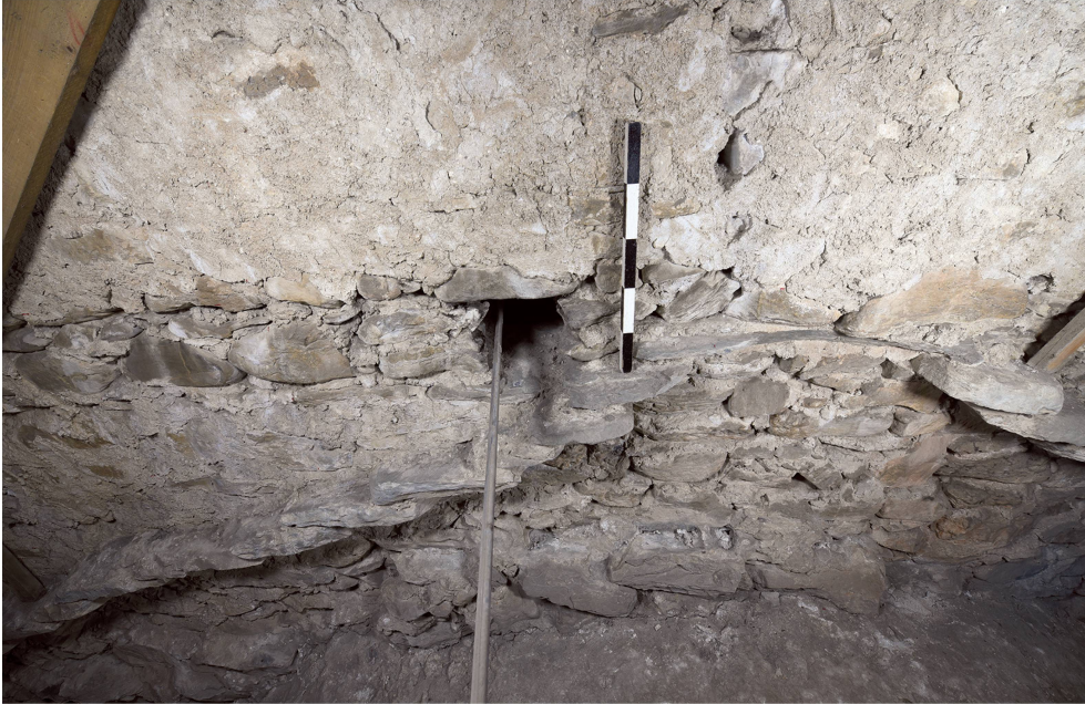
Abb. 2: Domat / Ems, Kirche Sogn Gion. 2021. Giebel-förmige Abdeckung aus vor-kragenden Steinplatten an der Ostfassade der Turm-ostmauer, aufgenommen im Dachstock des Schiffs. Die Platte am Scheitel ist abgebrochen. Blick gegen Westen.
