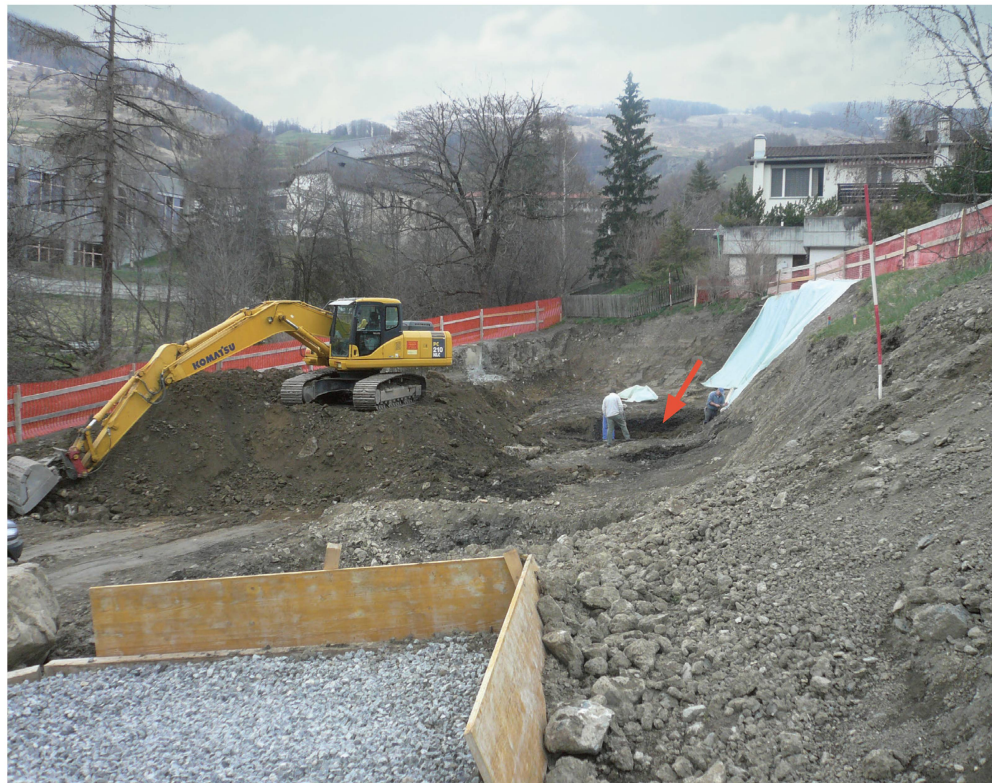
Abb. 3: Scuol, Avant Muglins. 2008. Die Baugrube nach dem Aussetzen der Aushub- arbeiten. Der schwarze Brandschutt ist im Sondier- schnitt deutlich zu erkennen (Pfeil). Blick gegen Süden.
