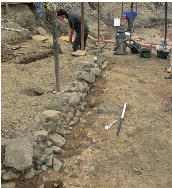
Abb. 12: Scuol, Avant Muglins. 2008. Zur Trockenlegung des östlichen Schwellbalkens des Gebäudeunterstandes sind Steine hinterfüllt. Blick gegen Süden.
