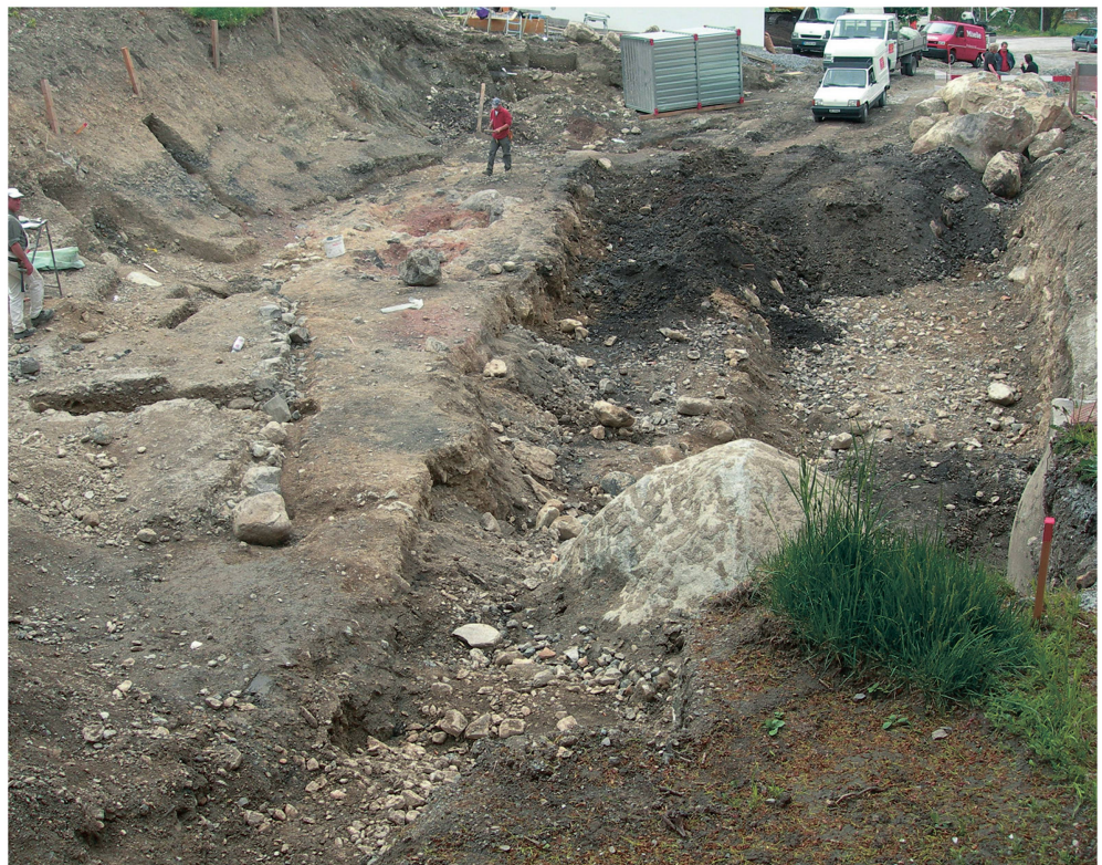
Abb. 4: Scuol, Avant Muglins. 2008. Das Baugelände nach Abschluss der archäologi- schen Untersuchungen. Die linke Hälfte wurde archäologi- gisch untersucht, die rechte Hälfte war bei Baubeginn bis auf das anstehende Rufen- material abgetragen worden. Blick gegen Süden.
