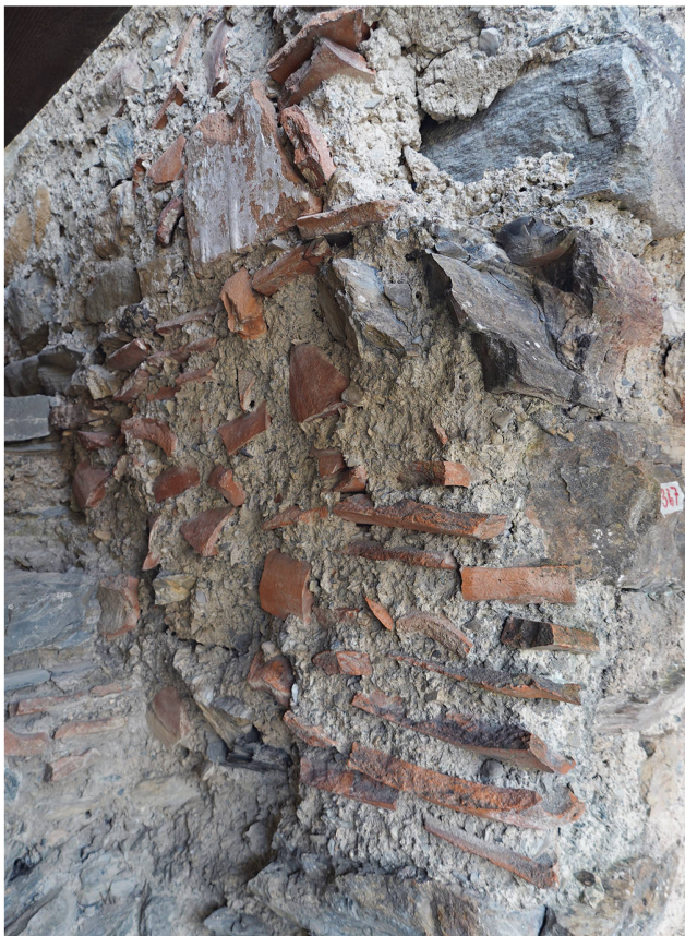
Abb. 2: Jenins, Neu-Aspermont. 2020. Grossflächige Reparatur aus Mörtel und darin verbauten Hohlziegelbruchstücken am Hauptturm. Blick gegen Südosten.
