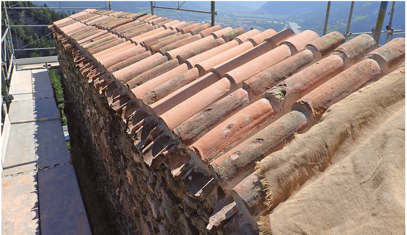
Abb. 7: Jenins, Neu-Aspermont. 2022. Die mit neu hergestellten Hohlziegeln ergänzte Kronenabdeckung des Wohnturms. Blick gegen Süden.
