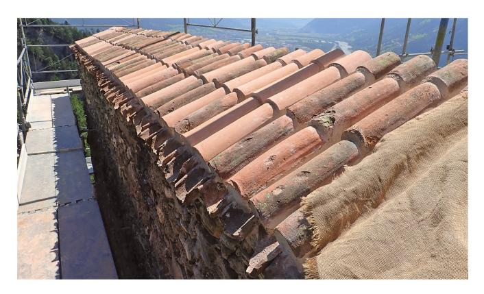
Abb. 7: Jenins, Neu-Aspermont. 2022. Die mit neu hergestellten Hohlziegeln ergänzte Kronenabdeckung des Wohnturms. Blick gegen Süden.
