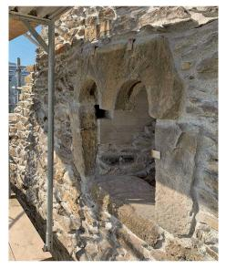
Für die Erhaltung des Turms war vor allem die bauliche Sicherung seines Daches wichtig. Die Steinplatten der ursprünglichen Dacheindeckung waren ohne Dachstuhl nur noch auf den Mauerkronen erhalten. Sie waren zum Teil noch intakt, lagen aber nicht mehr im festen Mörtel und rutschten langsam ab. Andere Platten hatten Risse, waren bereits sehr verwittert oder schon zerbrochen. Nach eingehender Prüfung unterschiedlicher Konservierungsmassnahmen
