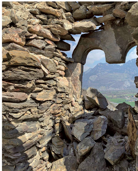
Abb. 7: Chur. Haldenstein, Burganlage Haldenstein. 2020/2021. Aus dem Mauerwerksverband der Nordostmauer gelöstes Biforenfenster vor der Konservierung. Blick ab Gerüst vom Burginnenraum gegen Nordosten.
