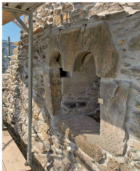
Abb. 8: Chur. Haldenstein, Burganlage Haldenstein. 2020/2021. Aussenansicht des Biforenfensters der Nordostmauer nach der Konservierung. Das Fenstergewände wurde in der vorgefundenen schiefen Lage baulich und statisch gesichert, die Natursteingewände durch sichtbare Metallwinkel in den rückwärtigen neuen Betonsturz rückverankert. Blick gegen Süden.
