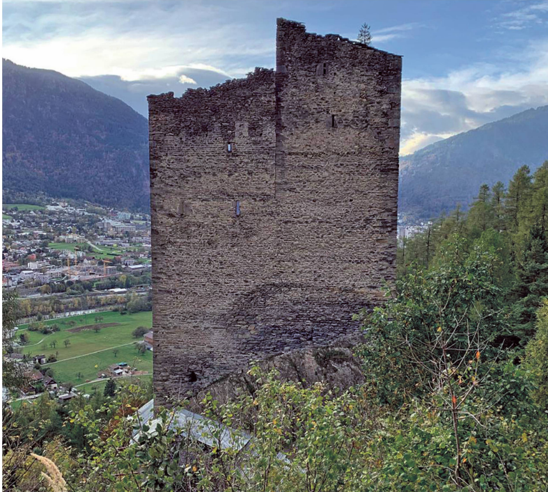
Abb. 4: Chur, Haldenstein, Burganlage Haldenstein. Burgruine Haldenstein im Oktober 2019 vor den Konservierungsarbeiten. Auf dieser Ansicht von Norden sind vor allem die aufgelösten Mauerkronen gut erkennbar. Blick gegen Süden.
