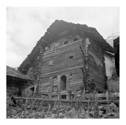
**Abb. 2:** Avers, Val Madris, Stettli. Viergeschossiger Speicherbau, sogenanntes Speicher-Schlafhaus. Foto um 1900.
