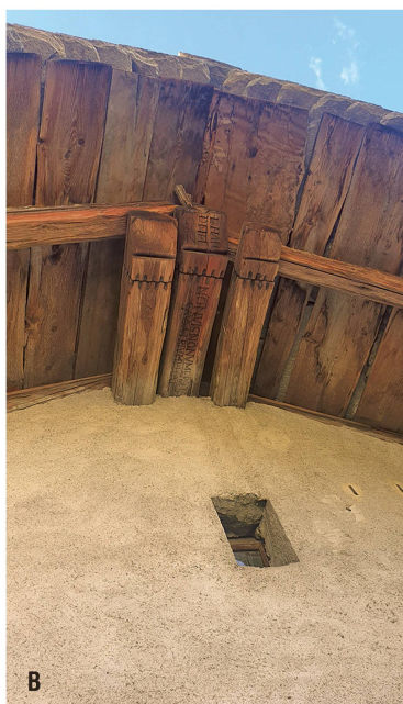
Abb. 6: Mit Kerbschnitt und Rillen verzierte Pfettenköpfe an Wohnhäusern in A Avers, Am Bach, Haus Nr. 77, in B Bregaglia, Stampa, Haus Nr. 7 und C Rheinwald, Nufenen, Dorfstrasse Nr. 19.
