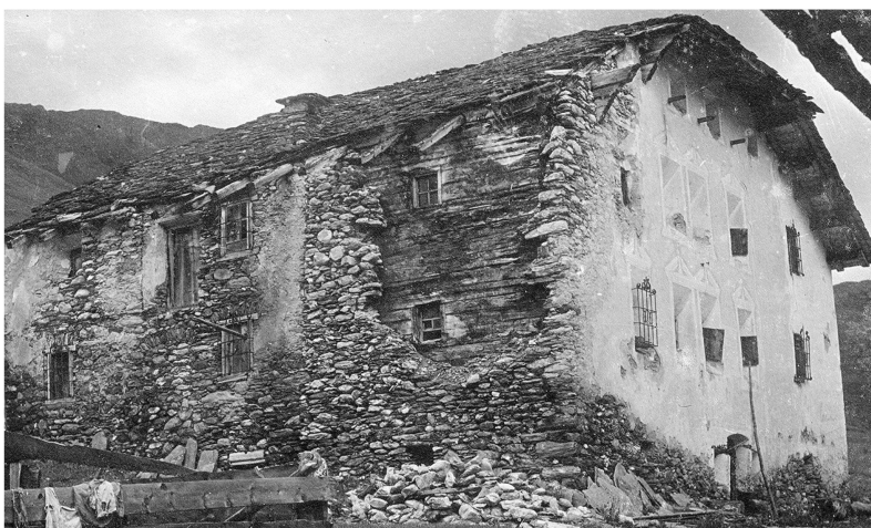
Abb. 10: Avers, Podestatenhaus. Der in Holz ausgeführte Kernbau von 1664 des Podestatenhauses ist mit Mauern ummantelt. Foto von 1910.
